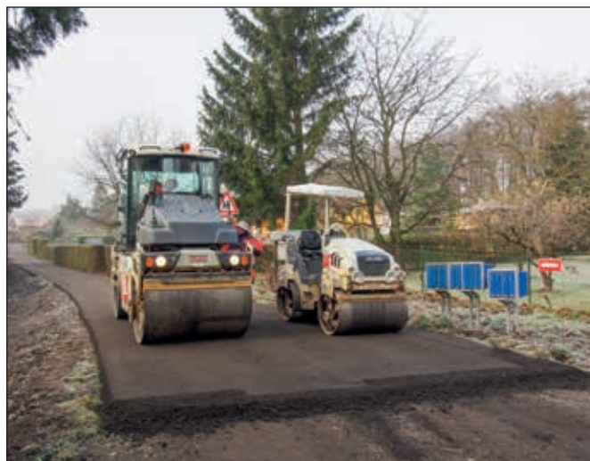
Silnička v ulici Višňovka už dostává nový kabát
