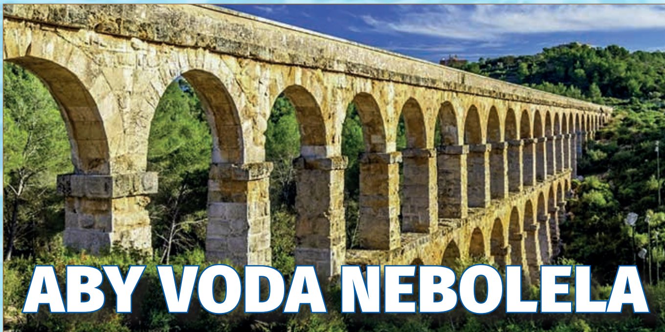
Obdobným akvaduktem jako je ten v katalánské Tarragoně se už tři stovky let před naším letopočtem přiváděla voda na zavlažování a pak i do měst
