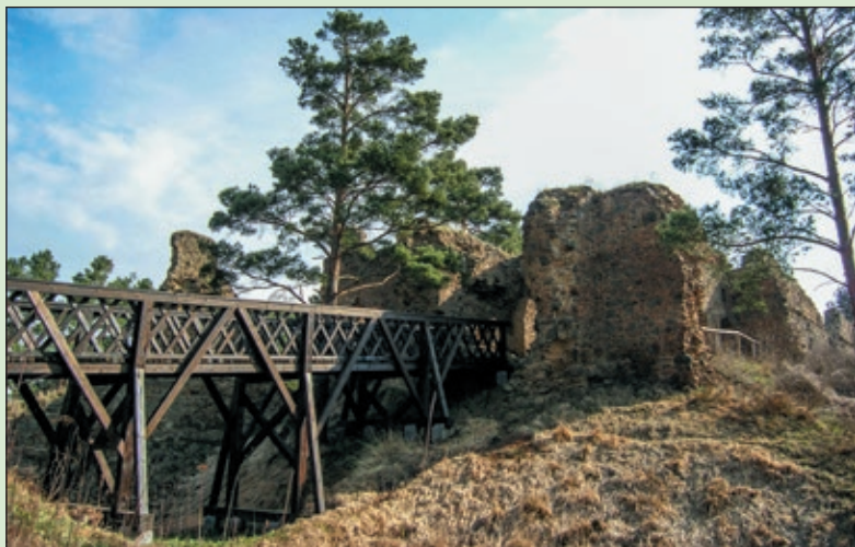
Nově zbudovaný mostek do kdysi pyšného sídla českých králů – hradu Vrškamýku
