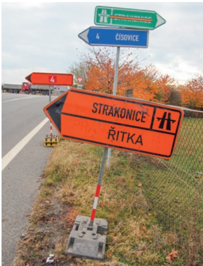
Nastal Den D, čili demoliční den 19. října 2019 a dočasné cedule musí stranou ze silnice
