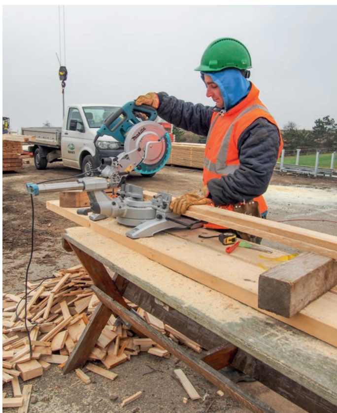
Tesaři připravují bednění pro betonáž, slangově šalunk
