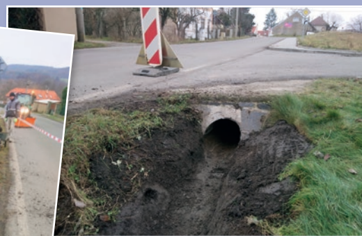
Obnova vodního žlabu v důsledku nánosů bahna po deštích
