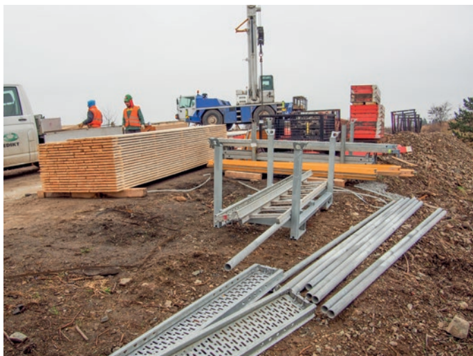
Tesaři připravují bednění pro betonáž, slangově šalunk
