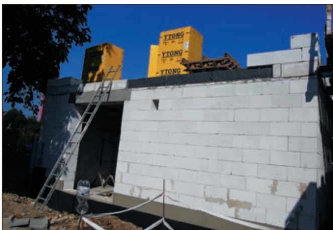
Výstavba nového objektu započala letošního léta (foto 17. 8.) ...
