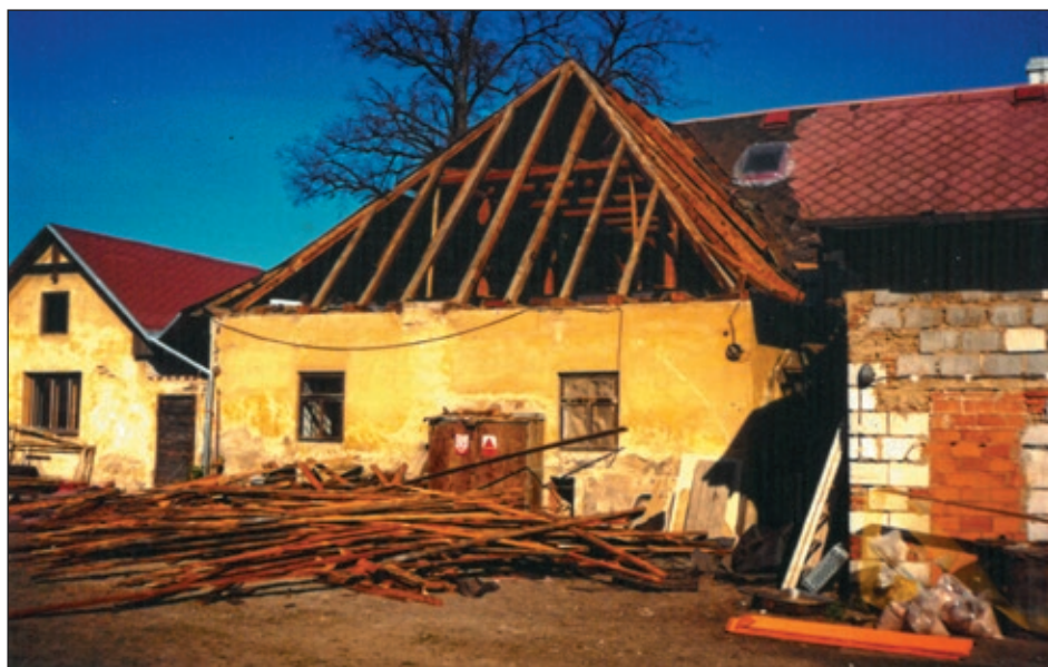
Pohled na rekonstrukci zadního traktu domu – 1999
