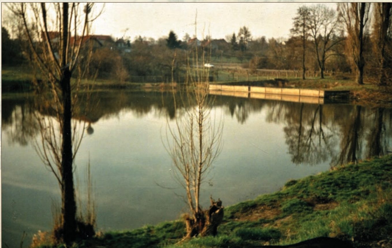
Poslední snímek s pohledem na brouzdaliště. Jaro 1999 před zahájením asanačních prací. Hráz byla odstraněna v květnu toho roku.
