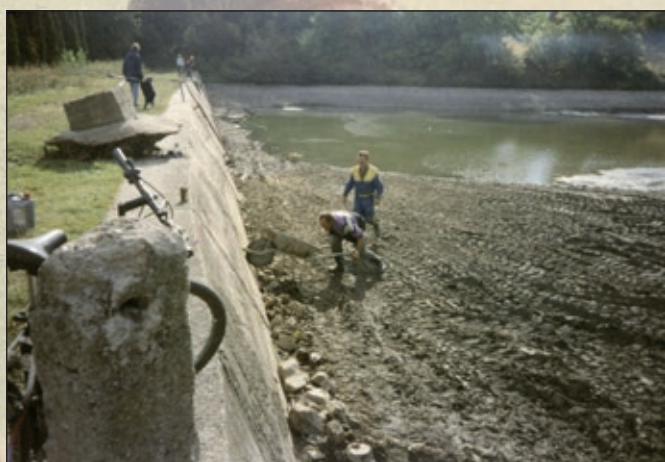
Členové spolku při opravě hráze a přepadové výpusti.
