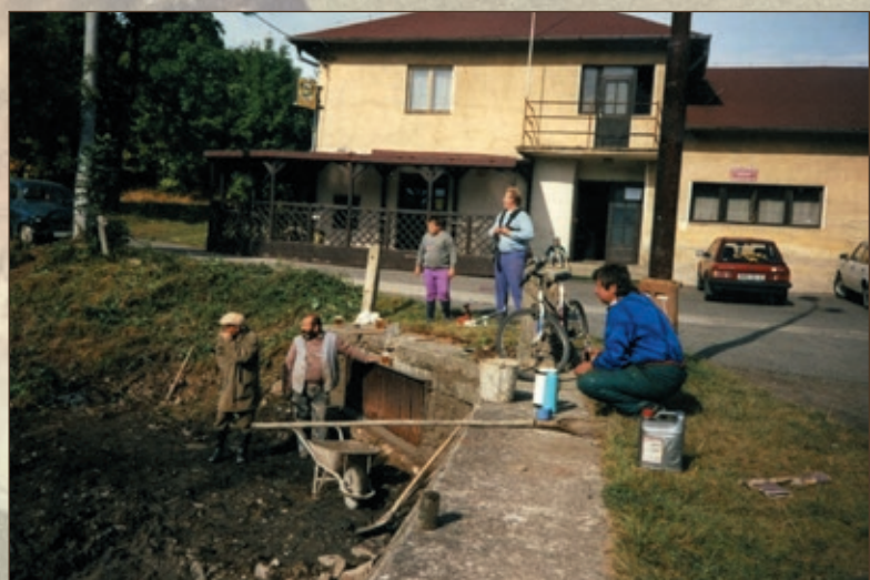
Toho roku se z gruntu mění břehový terén a porosty. Začíná se s pravidelnou údržbou, které je věnována péče dodnes.
