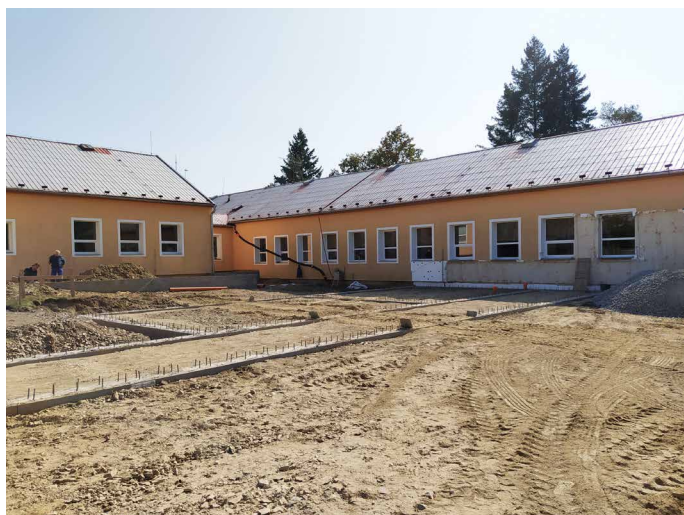
Zahájení stavby, srpen 2020
