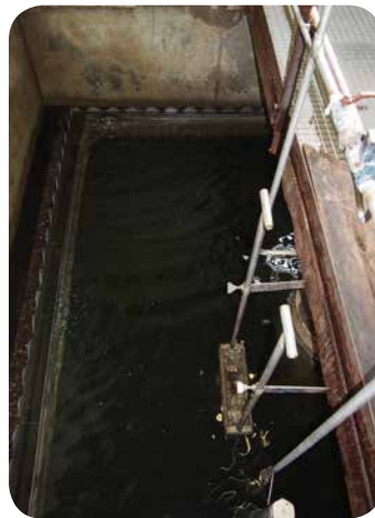
Dosazovací nádrž, ve které dochází k separaci vyčištěné odpadní vody od aktivovaného kalu. Vyčištěná odpadní voda odtéká přes přelivné hrany do odtokového potrubí
