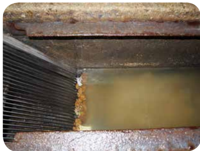
Hrubé předčištění odpadní vody – česle, tady se zachytávají shrabky
