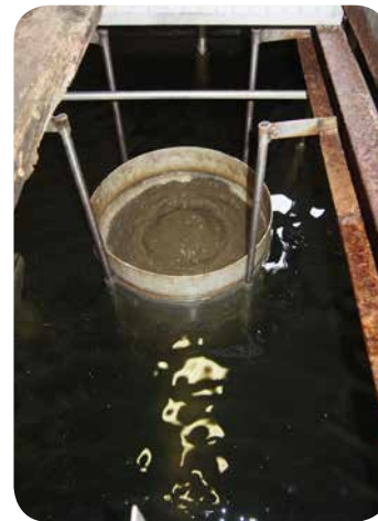
Dosazovací nádrž, ve které dochází k separaci vyčištěné odpadní vody od aktivovaného kalu. Vyčištěná odpadní voda odtéká přes přelivné hrany do odtokového potrubí
