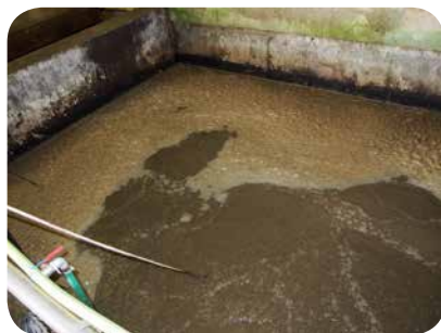
Provozdušňovaná nitrifikační nádrž čistírny, probíhá tu oxidace organických látek a amoniakálního dusíku
