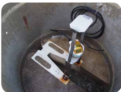
Odtok vyčištěné odpadní vody přes měrný objekt
