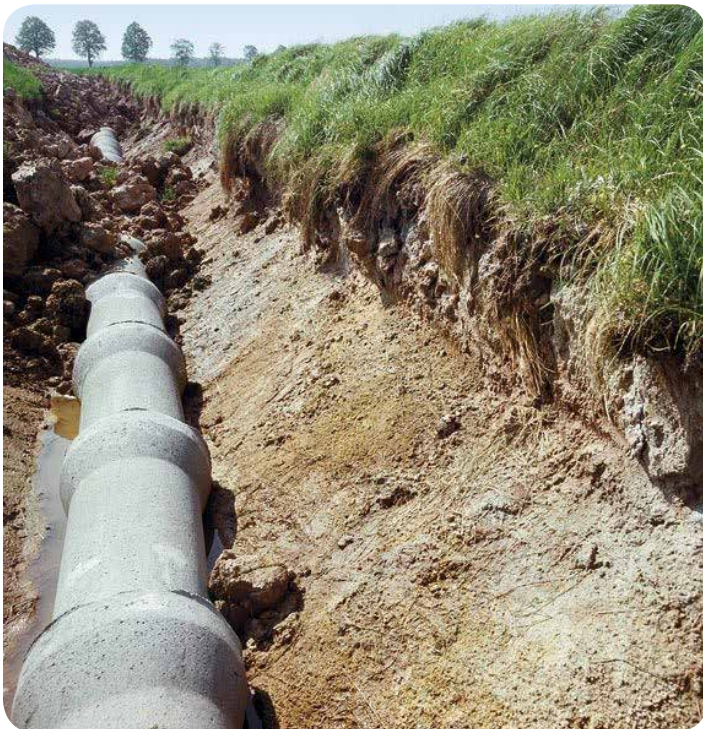
Za komunismu nedomyšlené meliorace doslova ukradly polím i loučkárnou vodu. (Foto: časopis Vesmír)
