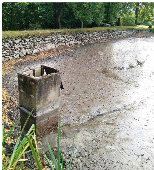
Vypuštěný rybník čeká na opravu.
