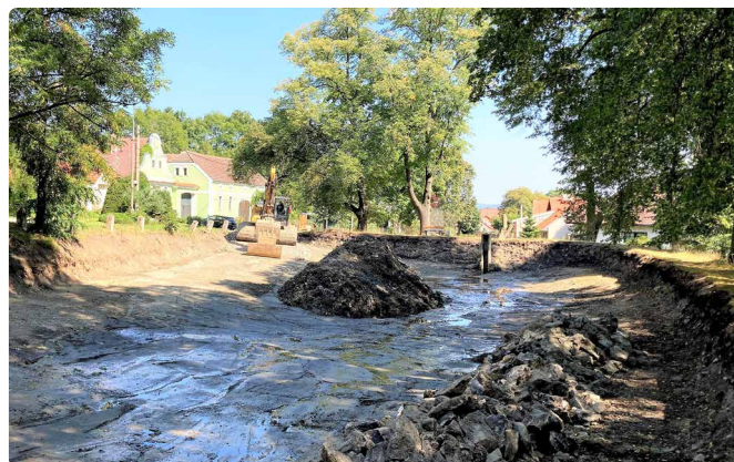
Průběh stavby – bourání zdiva a odtěžení sedimentů ze dna.
