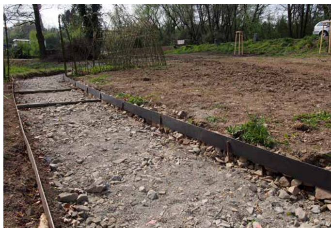
Mlatová cesta bude bytelně zpevněna kovovými bočnicemi
